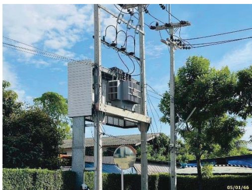
หม้อแปลงไฟฟ้า ขนาด 800 KVA พร้อมตู้ควบคุมไฟฟ้าอาคาร D
