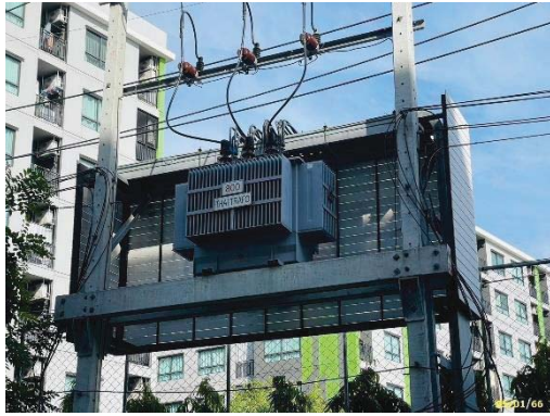
หม้อแปลงไฟฟ้า ขนาด 800 KVA พร้อมตู้ควบคุมไฟฟ้าอาคาร E
